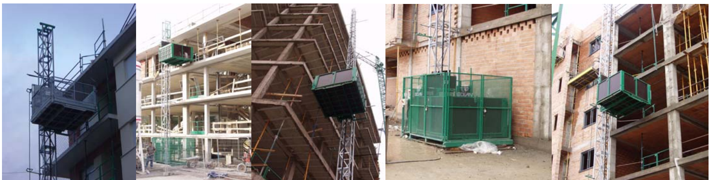
Montacargas para obra / Material Hoist Obra Nueva / New Building
